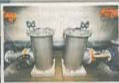
Boven: in de kelder staan haarfangers, die haren uit het water filteren. Onder: het nieuwe bad heeft veel glas.
